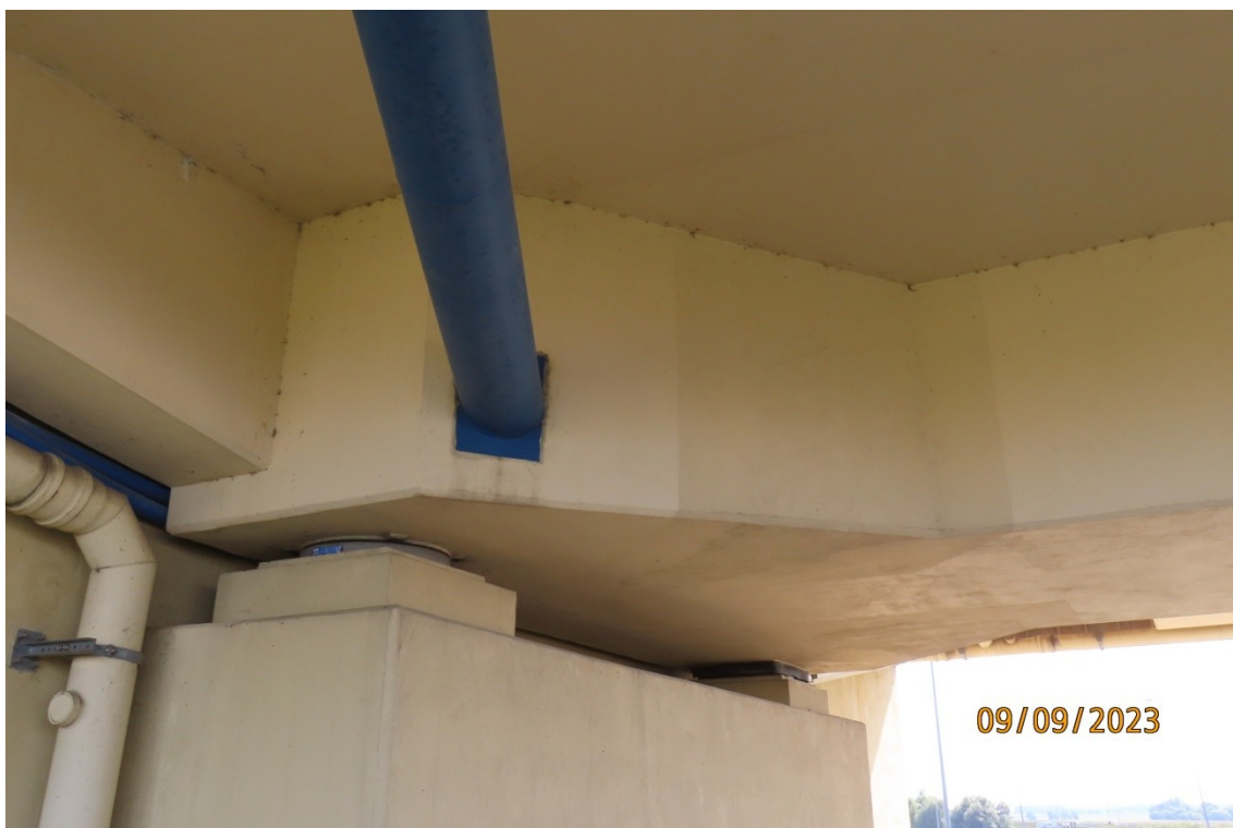
Fot. 19. Oparcie przęsła na przyczółku od strony Pyrzyc - widok od strony północnej.
