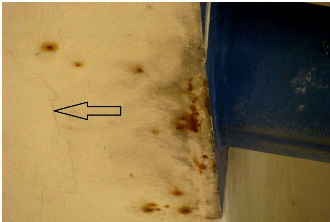
Fot. 29. Rdzawe wykwity i zarysowania betonu na spodzie dźwigara w miejscu zamocowania zastrzału konstrukcji pomostu, spowodowane korozją zbrojenia.
