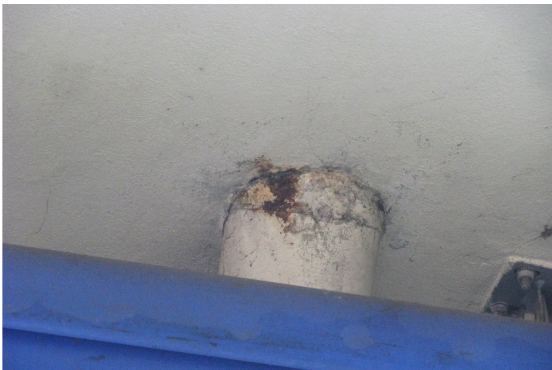
Fot. 15. Korozja żeliwnego króćca wylotu wpustu odwodnienia jezdni.
