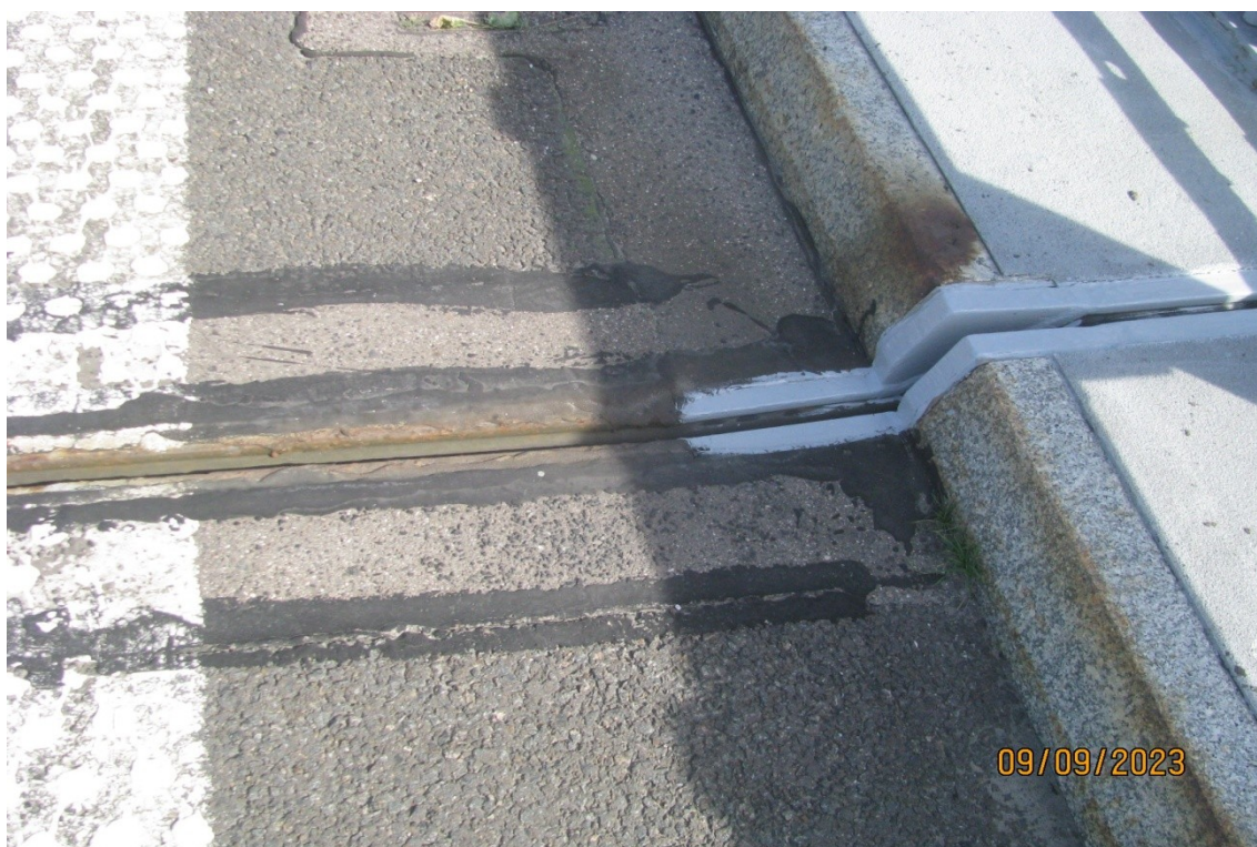
Fot. 16. Korozja stalowych profili dylatacji modułowej, częściowo naprawiona.
