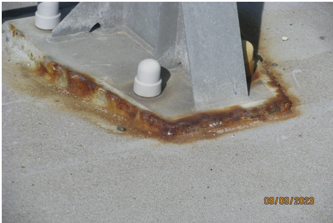
Fot. 11. Korozja w obrębie podstawy słupka bariery.
