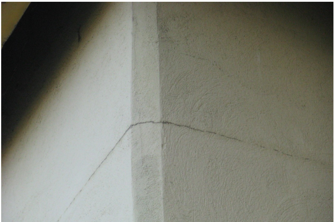
Fot. 18. Spękania betonu korpusu przyczółka od strony Krajnika Dolnego.
