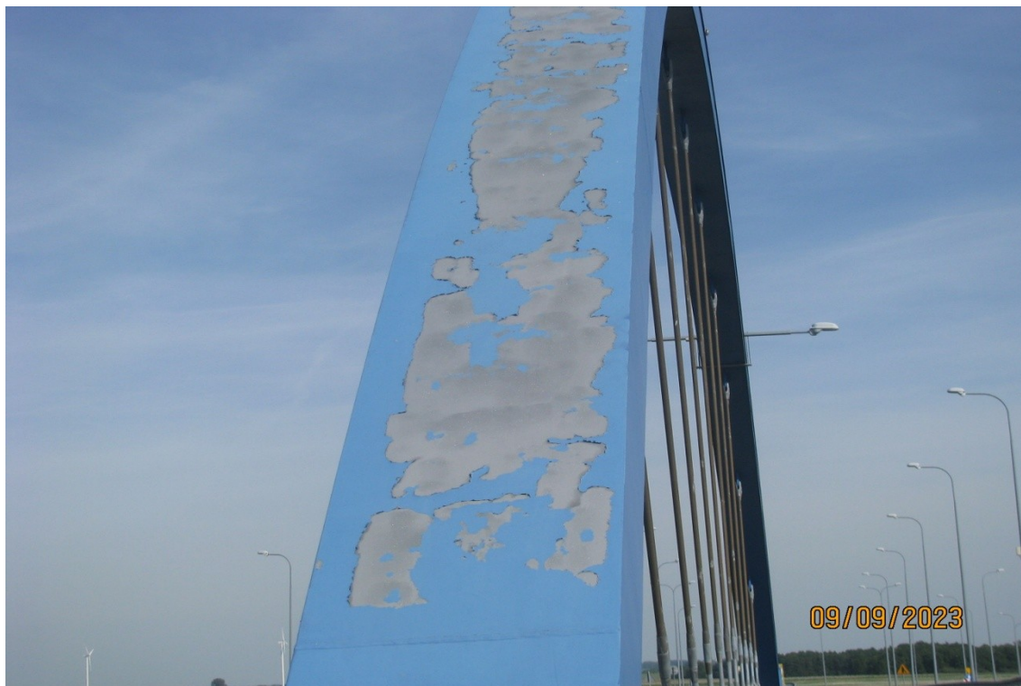
Fot. 13. Ubytki powłoki malarskiej na powierzchni stalowej konstrukcji łuku od strony Krajnika Dolnego.
