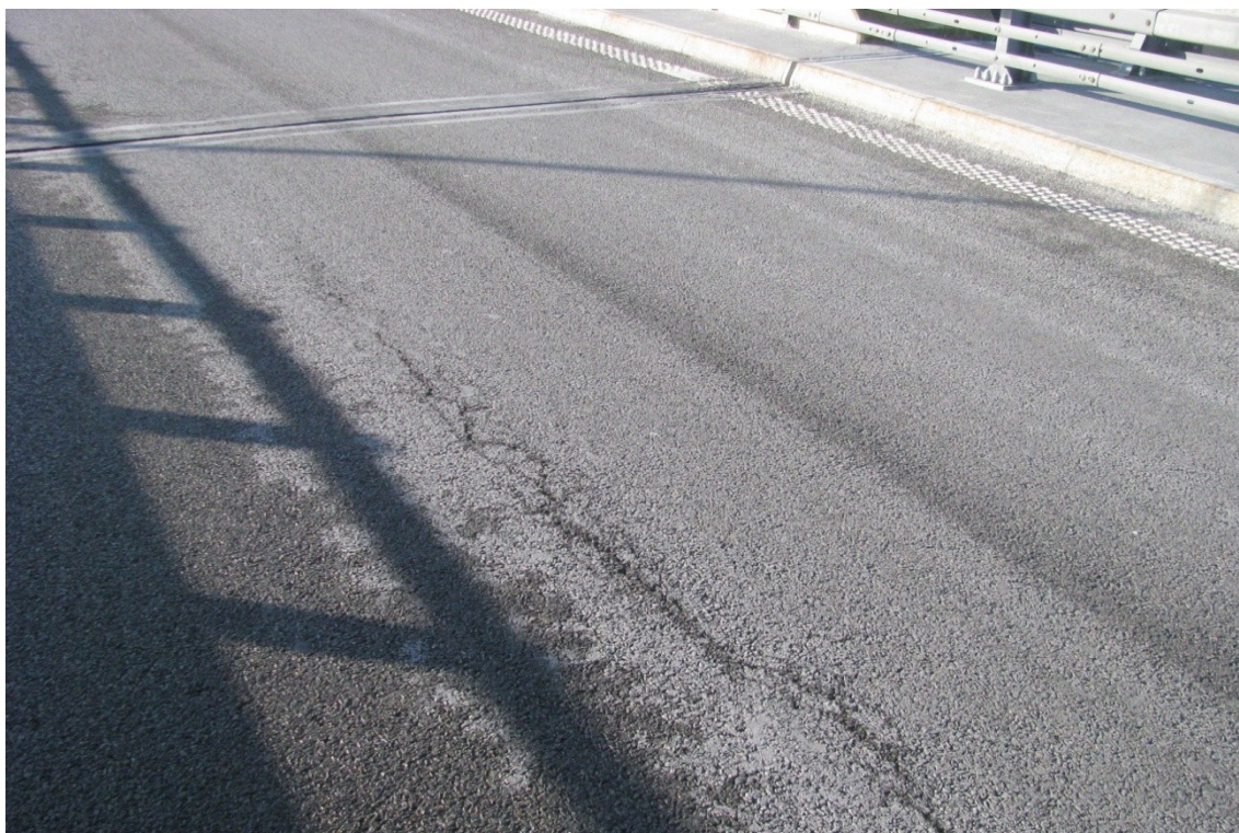
Fot. 9. Spękania nawierzchni jezdni na dojeździe w obrębie skrzydeł przyczółka.
