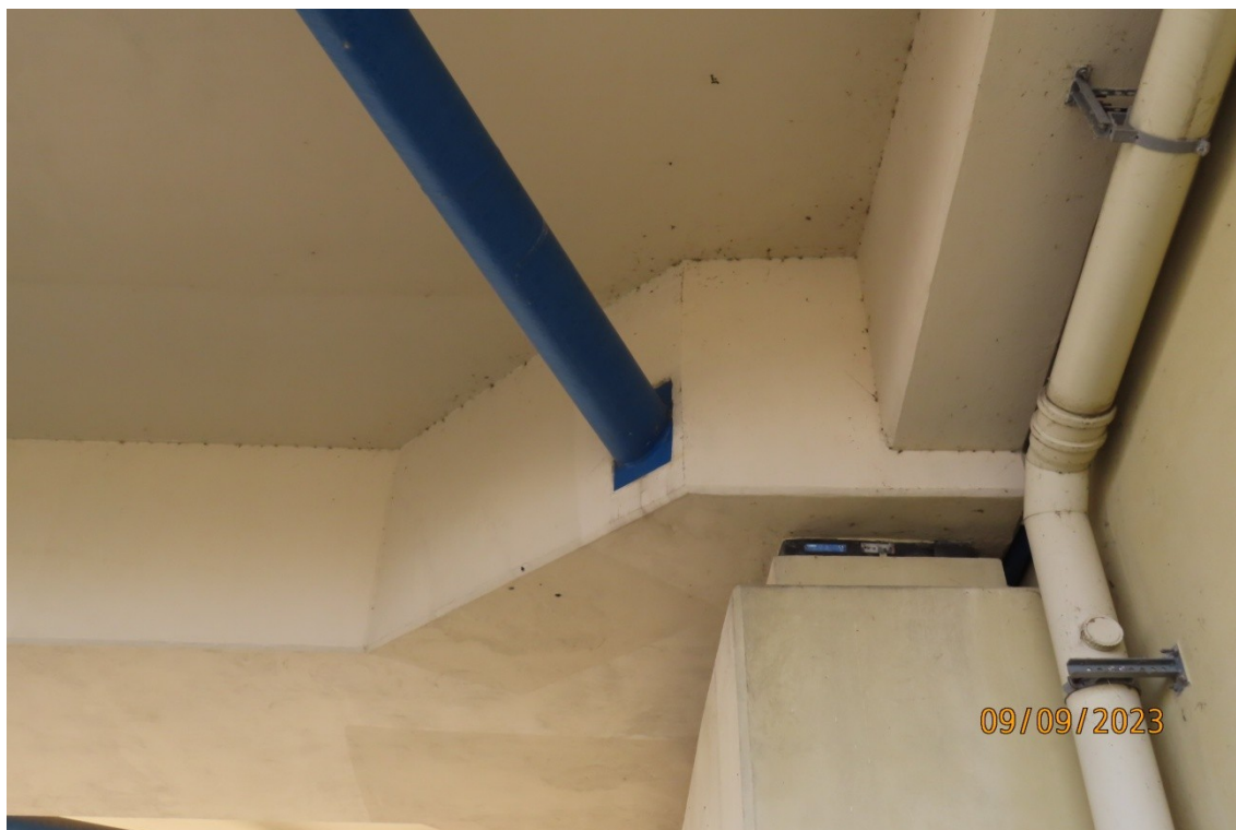
Fot. 27. Oparcie przęsła na przyczółku od strony Krajnika - widok od strony północnej.
