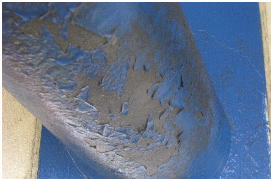
Fot. 12. Ubytki powłoki malarskiej na konstrukcji zastrzałów podpierających płytę pomostu.
