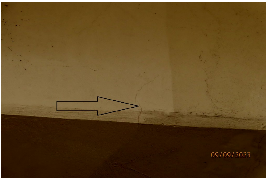
Fot. 26. Szczegół zarysowania betonu poprzecznicy podporowej ze zdjęcia nr 25.
