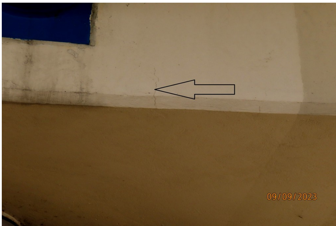
Fot. 21. Szczegół zarysowania betonu poprzecznicy podporowej z zdjęcia nr 19.
