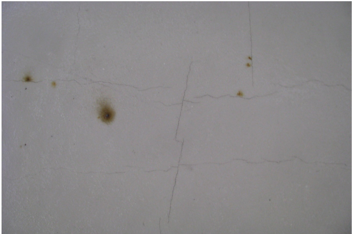
Fot. 33. Szczegół uszkodzeń korozyjnych ze zdjęcia jw - rdzawe wykwity i zarysowania betonu spowodowane korozją zbrojenia.
