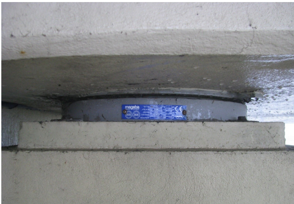
Fot. 6. Łożysko stałe na przyczółku.
