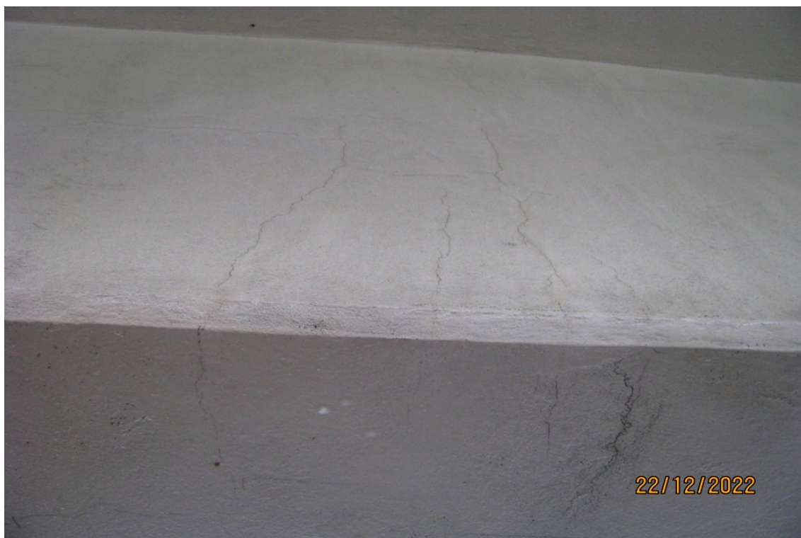
Fot. 36. Zarysowania betonu dźwigara sprężonego konstrukcji w przęśle nad jezdnią.
