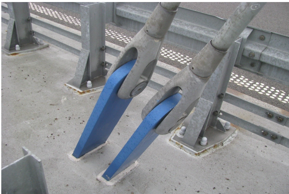
Fot. 8. Widok zamocowania wieszaków w konstrukcji dźwigara sprężonego.
