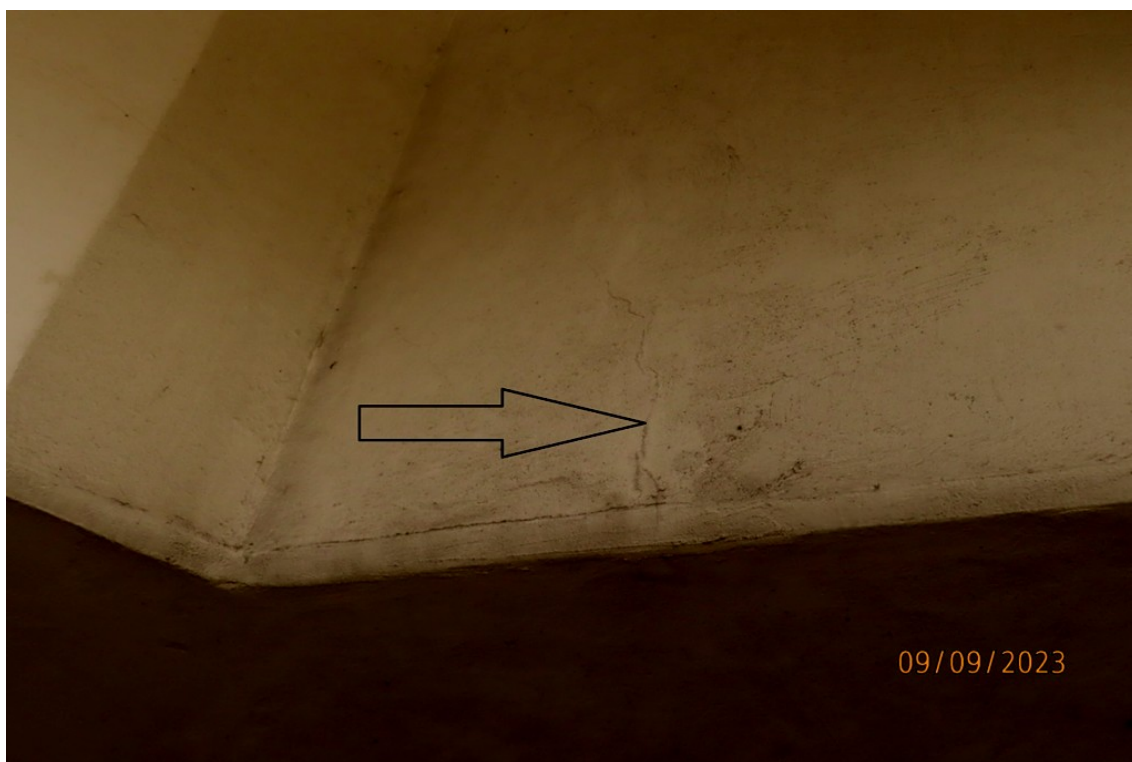
Fot. 24. Szczegół zarysowania betonu poprzecznicy podporowej ze zdjęcia nr 23.
