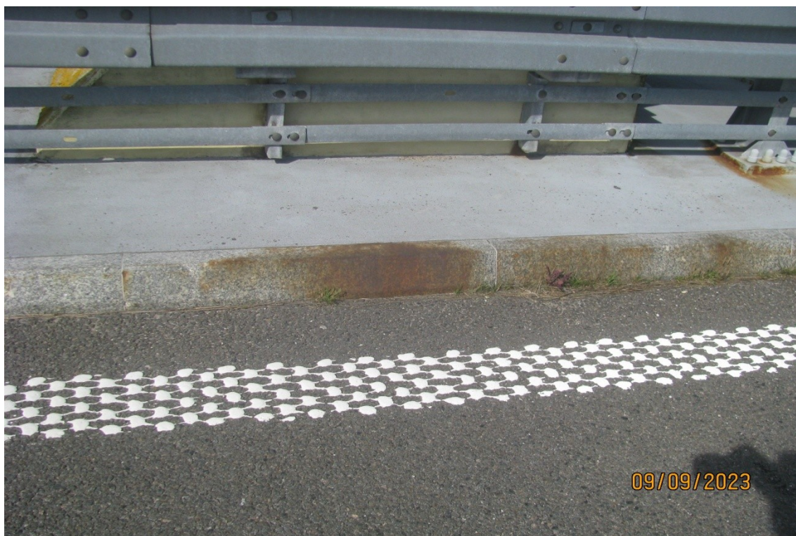
Fot. 10. Rdzawe wykwity na krawężniku spowodowane korozją zakotwienia w kapie.
