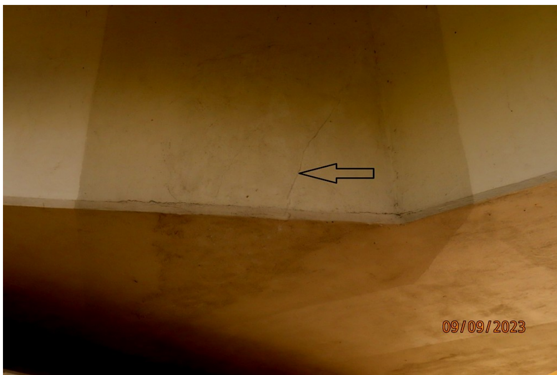
Fot. 22. Szczegół zarysowania betonu poprzecznicy podporowej ze zdjęcia nr 19.
