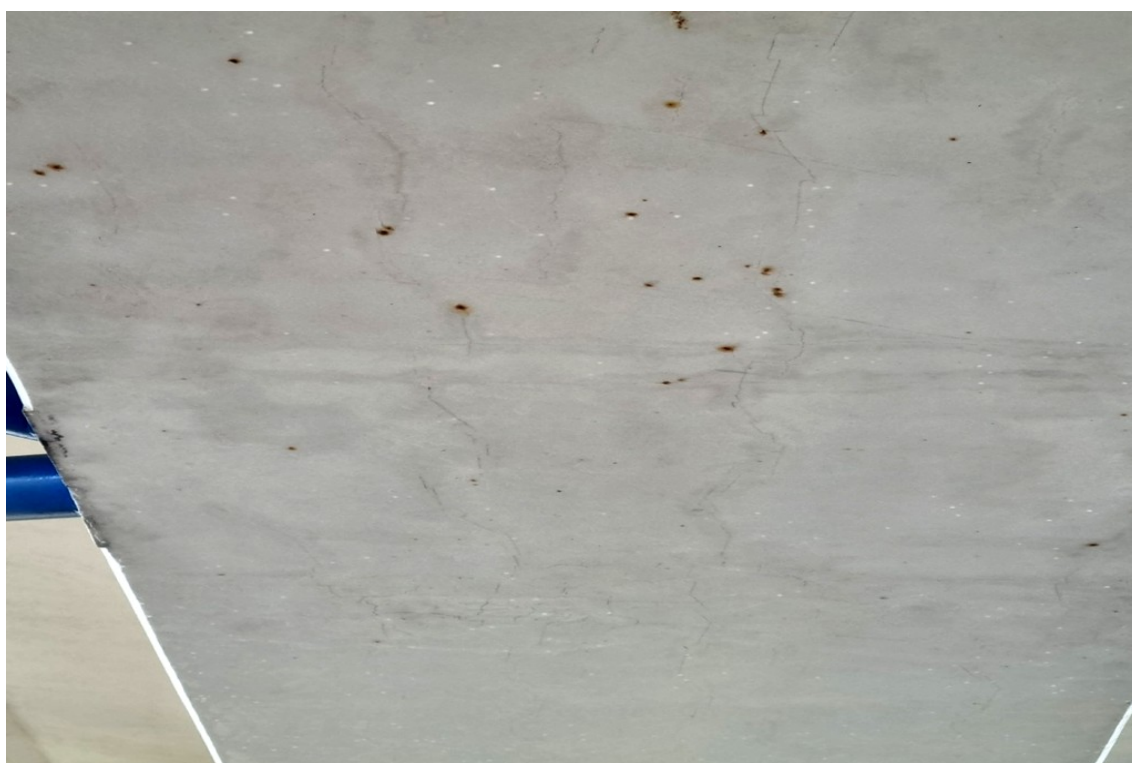
Fot. 32. Szczegół uszkodzeń korozyjnych ze zdjęcia jw - rdzawe wykwity i zarysowania betonu spowodowane korozją zbrojenia.
