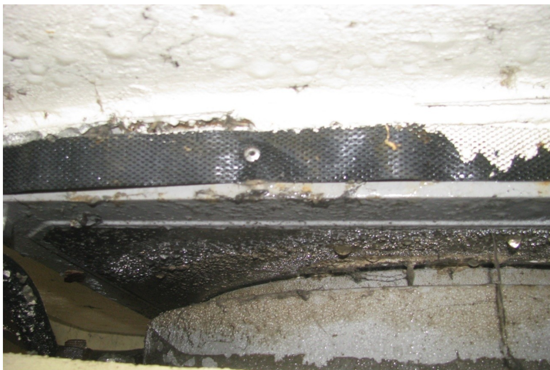
Fot. 14. Osady i zanieczyszczenia na powierzchni łożyska. Pojedyncze ogniska korozji.
