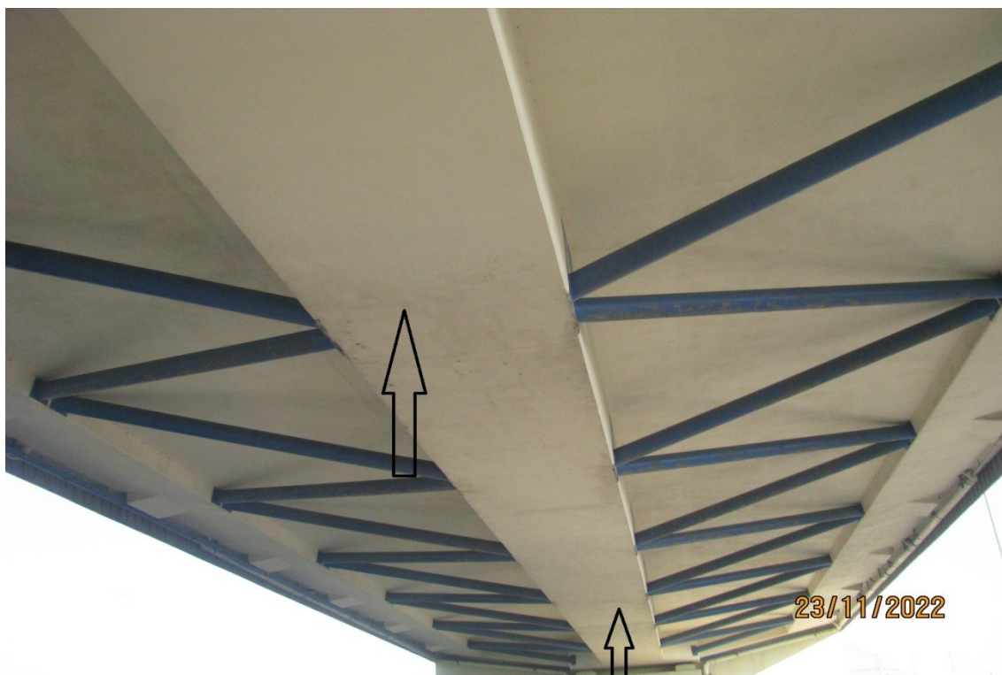
Fot. 31. Usytuowanie uszkodzeń korozyjnych na spodzie dźwigara - nad obiema jezdniami.
