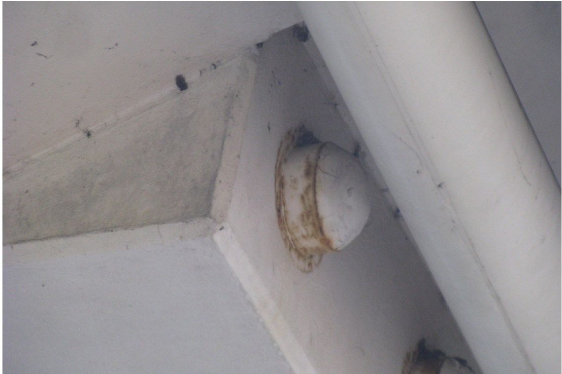
Fot. 17. Ogniska korozji na osłonie zakotwienia kabli sprężających płytę pomostu.
