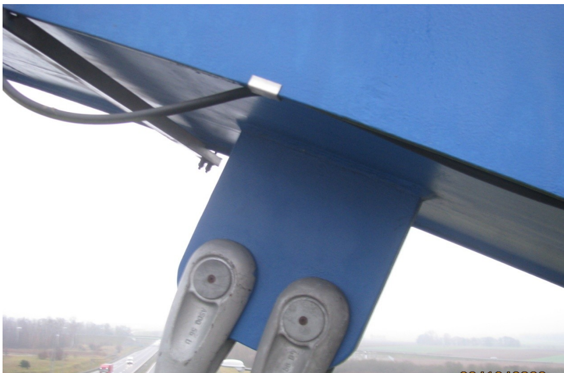
Fot. 7. Widok zamocowania wieszaków w konstrukcji łuku stalowego.
