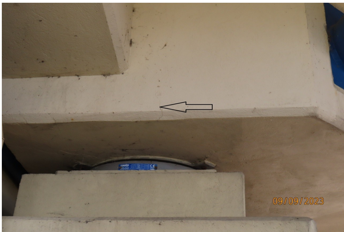
Fot. 20. Szczegół zarysowania betonu poprzecznicy podporowej ze zdjęcia nr 19.
